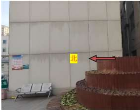
图 3-1 DSA 机房北侧医院内道路
