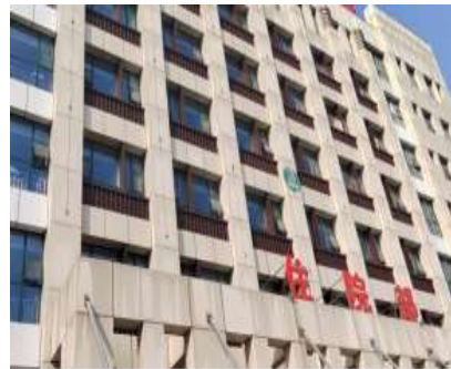
图 3-4 DSA 机房西北侧住院部①
